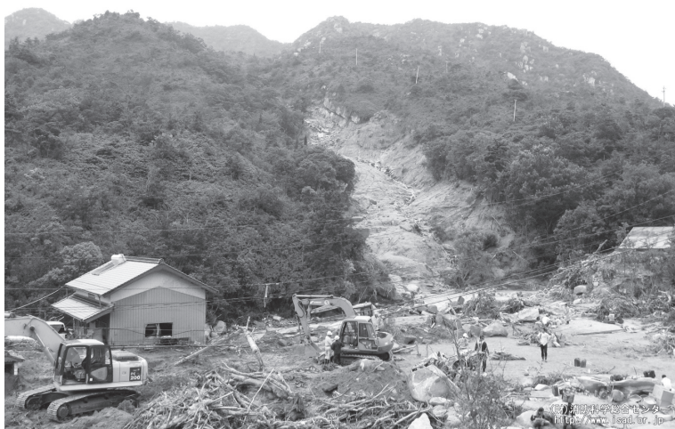
写真2 土砂災害現場〔平成21（2009）年7月の中国・九州北部豪雨〕（災害写真データベースより）
