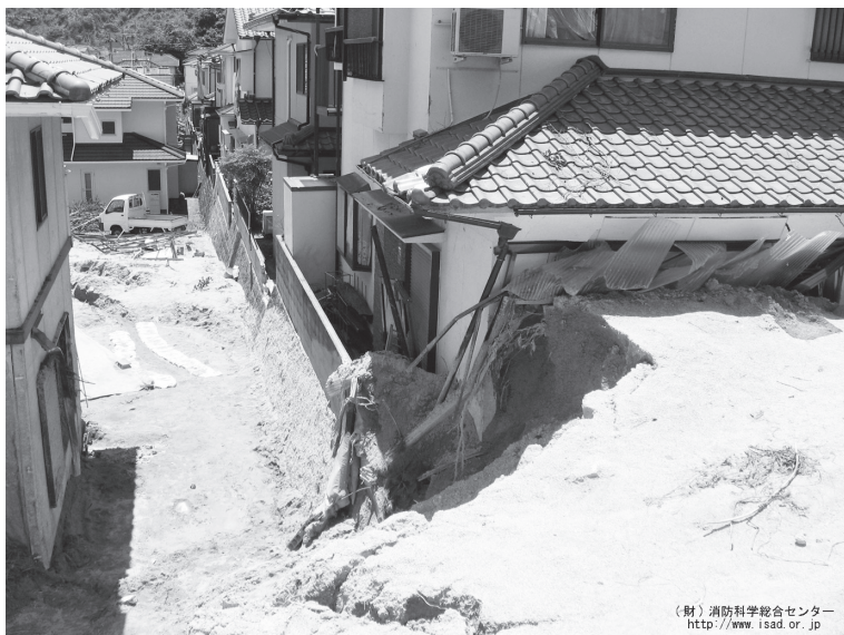
写真1 住宅に流入した土砂〔平成22（2010）年の梅雨期における大雨災害〕 （災害写真データベースより）
