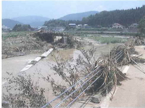
図-1.4 田尻新橋の被害状況(出典：榎田)
