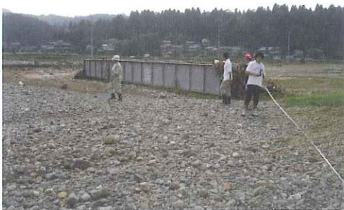
(b) 堤内地に侵入した橋桁(河道寄りから撮影) (出典: 榎田)
