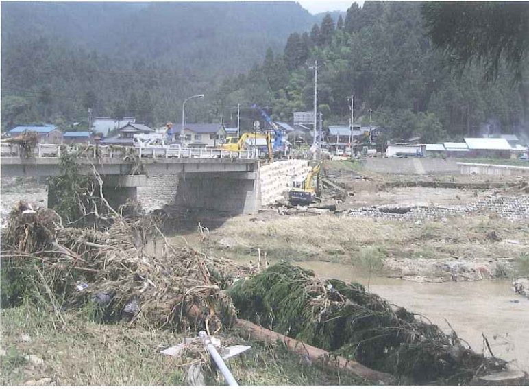
2004年福井豪雨による足羽川の 高田大橋付近における被害 (上流左岸より)
