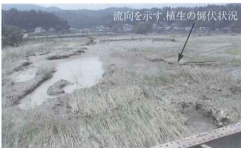
(d) 下流右岸の高水敷の侵食と破堤の状況 (出典: 榎田)
